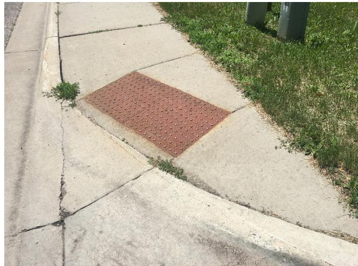
FIGURE 2 NON COMPLIANT CURB RAMP IN ALEXANDRIA
